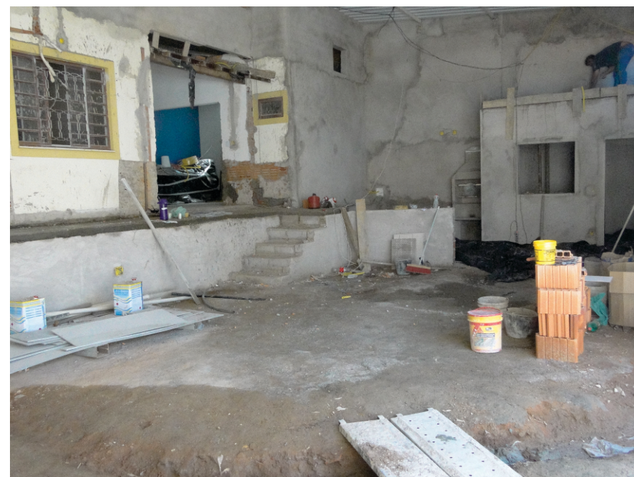
Área interna do SINTPq Campinas. Atualmente em reforma, abrigará um novo espaço de lazer para os sócios
